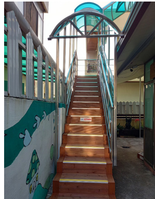
삼방공부방 건물 외부 이동통로 우천시설
